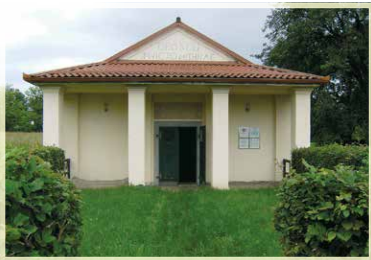
Foto/Photo by: Janja Šterbal Vindiš
